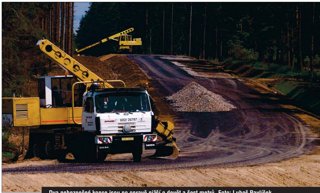
Dva nebezpečné kopce jsou po opravě nižší o devět a šest metrů. Foto: Luboš Pavlíček
